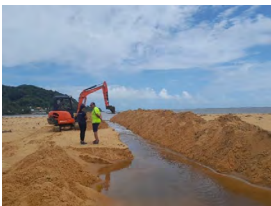
Ouverture de l'exutoire, mars 2023
