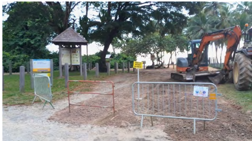
Réfection du parking en septembre 2021.
