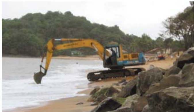
Tavaux de remblaiement sur un site de ponte (© K. Pineau)
